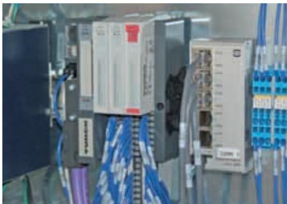
**Das Remote-I/O-System BL20 bringt die Peripherie-Signale per Profibus an die Steuerung**
